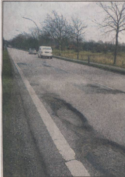
Kornweide: Die schlimmsten Kanten sind mittlerweile mit Teer geglättet worden. Foto: Stöhr
